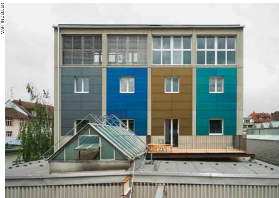
L'ancien silo à charbon au Gundeldinger Feld à Bâle. Les modules photovoltaïques colorés sur les cloisons et sur le toit sont couplés à une batterie 2nd-Life depuis l'automne 2015.
